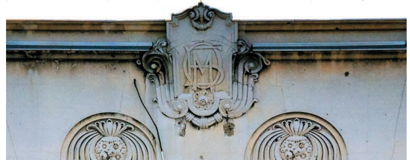
Детаљ фасаде / Detail of the façade
