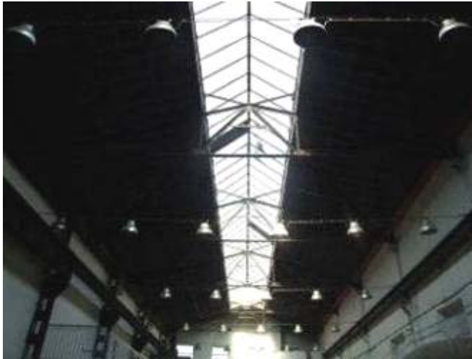
Исти тип крова на машинској хали која данас служи као депо и изложбени простор Музеја – двоводни кров са решеткастим металним кровним носачима и кровни светларник дуж слемена крова, кранске стазе на зидовима
