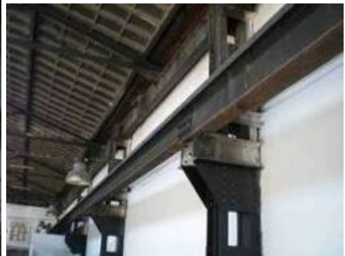
Исти тип крова на машинској хали која данас служи као депо и изложбени простор Музеја – двоводни кров са решеткастим металним кровним носачима и кровни светларник дуж слемена крова, кранске стазе на зидовима
