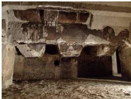
Лево: Подрум, отвори за сакупљање млевеног угаљ. Млевени угаљ (у облику прашине) је пролазио кроз конусе у подруму, и убациван је у подруму у ложишта котлова. Десно. Подрум, отвори за сакупљање шљаке
