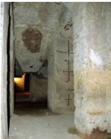
Лево: Подрум, отвори за сакупљање млевеног угаљ. Млевени угаљ (у облику прашине) је пролазио кроз конусе у подруму, и убациван је у подруму у ложишта котлова. Десно. Подрум, отвори за сакупљање шљаке
