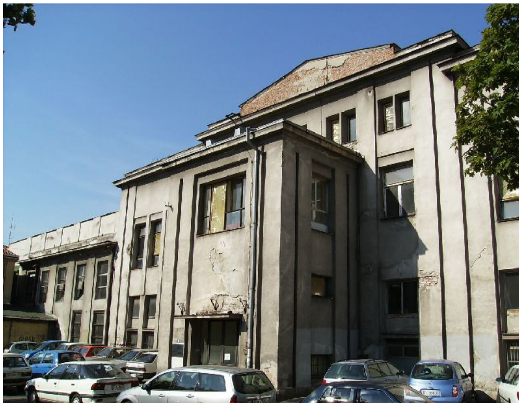
Zgrada Muzeja nauke i tehnike pre početka rekonstrukcije
