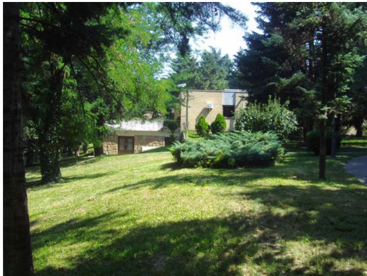
Položaj spoljnog zida levog apartmana u kome se pojavljuje povećana vlaga i ulaz u depo
